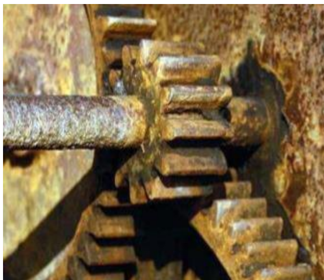
2.3-сурет - Коррозиямен зақымданған аймақтар
